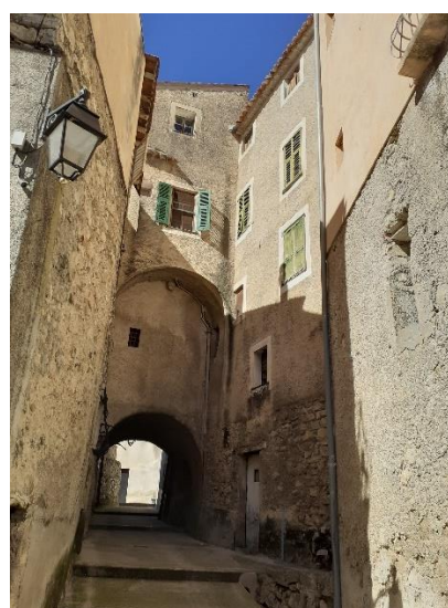
Figure 3 - Vue du passage couvert rue du presbytère
