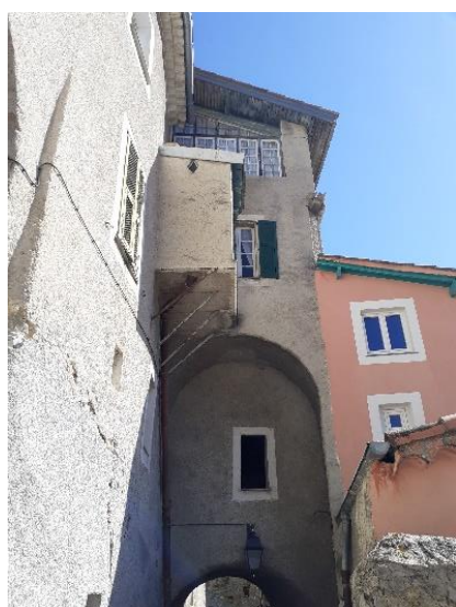
Figure 2 - Vue du passage couvert rue du presbytère
